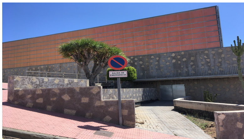
PUERTA DE SALIDA DEL RECINTO
